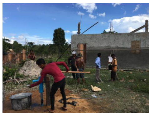
Les ouvriers effectuent les travaux d'installation d'un puits à pompe manuelle en faveur de la population de Sokrun
