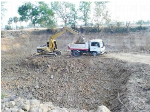
Vue d'ensemble des travaux de creusement du nouveau bassin de rétention
