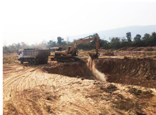
Commencement des travaux de creusement du bassin de rétention dans le village de Samrong
