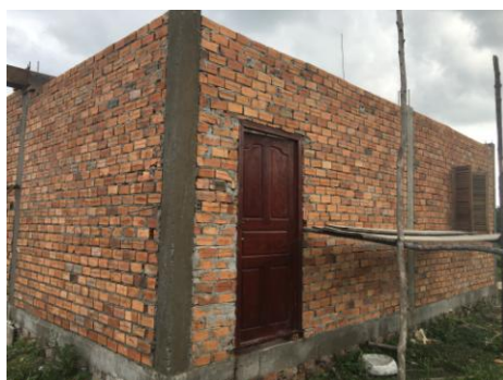
Le nouveau bâtiment de la nouvelle école pendant sa construction.
